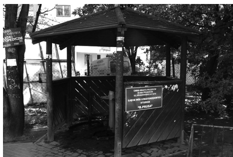
Fot. 5. Ujęcie wody z pokładów czwartorzędowych, eksploatowanej z głębokości 29,5 m p.p.t., przy ul. Prusa
