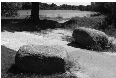
Fot. 14. Dwa granity blokują wjazd dużych pojazdów na ścieżkę wokół Zalewu Komorowskiego
