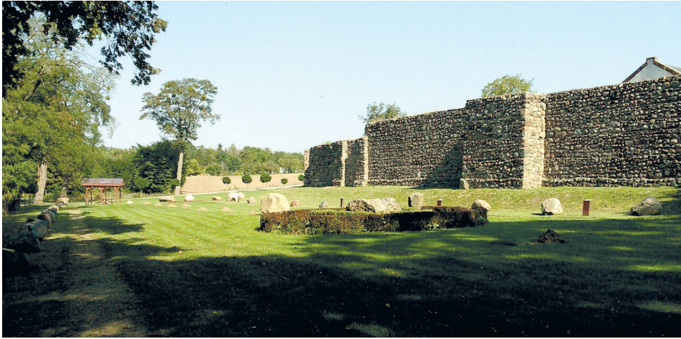
Fot. 3. Fragment zachodniej części murów miejskich w Moryniu był przedmiotem szczegółowej analizy petrograficznej oraz analizy eratyków przewodnich i wskaźnikowych. U podnóża murów znajduje się ogródek skalny (stan w 2011 r.)
